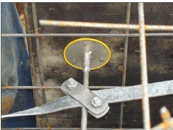
Kontaktplattan monterad innan gjutning.
